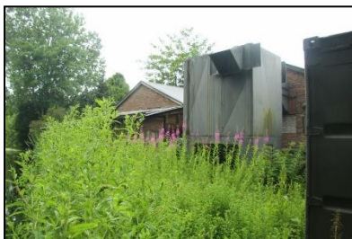
Figuur 6. Zuidelijke gevel van de geschakelde loodsen, maat daarop aansluitend de houten schuur.
