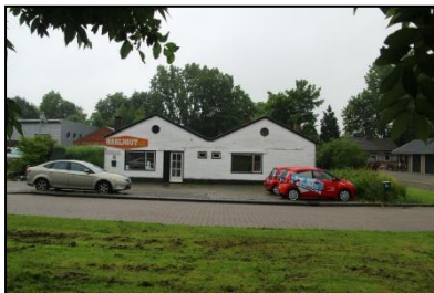
Figuur 3. Noordelijke gevel van de geschakelde loodsen.
