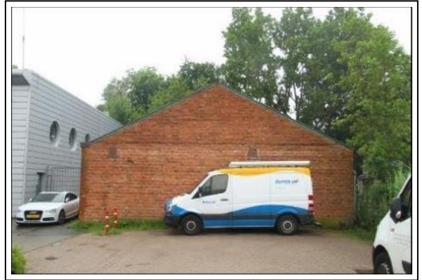
Foto 2 Noordelijke gevel losstaande loods (Econsultancy).
