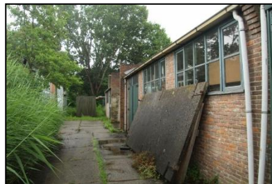
Figuur 4. Oostelijke gevel van de geschakelde loodsen.
