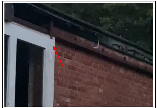
Foto 4 Zomerverblijfplaats gewone dwergvleermuis achter schuifdeur losstaande loods.
