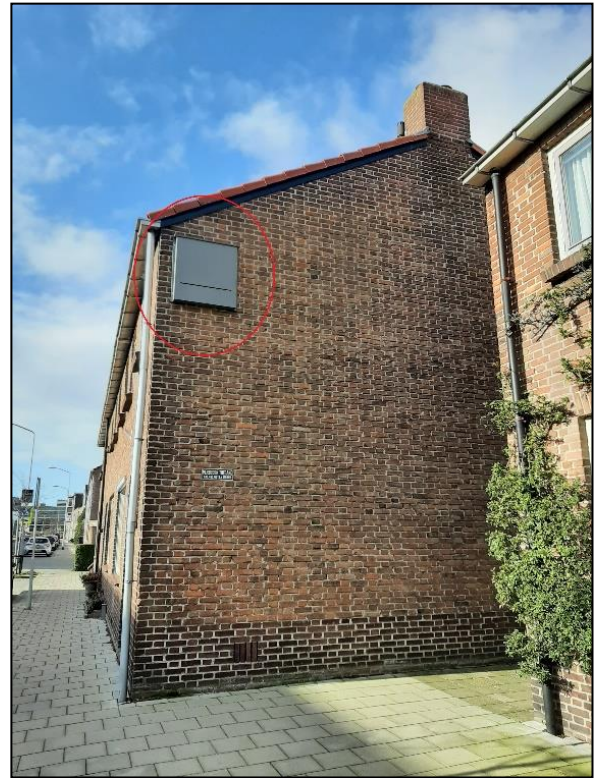
Figuur 8. 1x VMT3 kraamkast aan Nieuwstraat 37.
