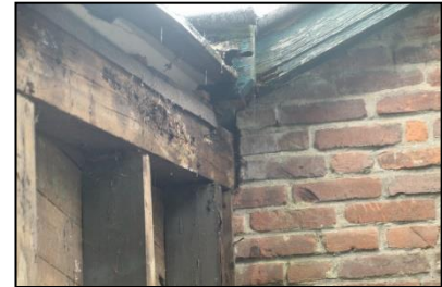
Figuur 15. Ruimte tussen bakstenen en houten balk, aanwezig in de zuidelijke gevel van de geschakelde loodsen.
