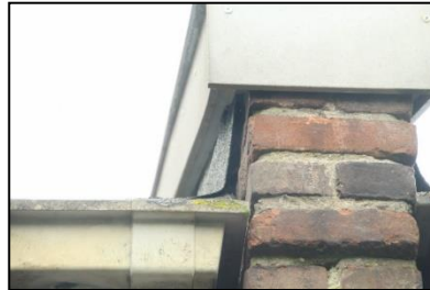
Figuur 14. Ruimte onder de dak bekleding, aanwezig bij de noordelijke gevel van het woonhuis.
