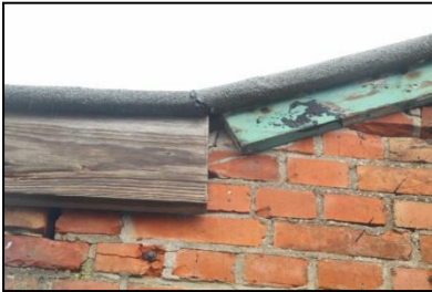
Figuur 13. Ruimte bij betimmering, aanwezig bij de noordelijke gevel van de geschakelde loodsen.
